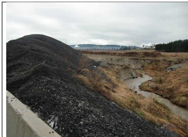
lagring av granulert asfalt ved bekk
