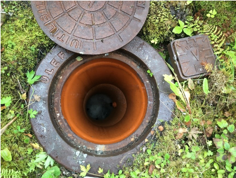
Bilete 1. Manglande ventil frå fordrøyningstank.
