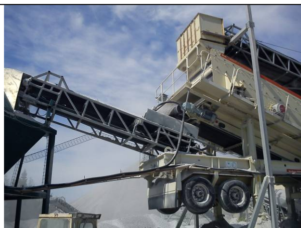
Detaljer fra finverket –ferdigvarehaugen bak er delvis skult av støv
