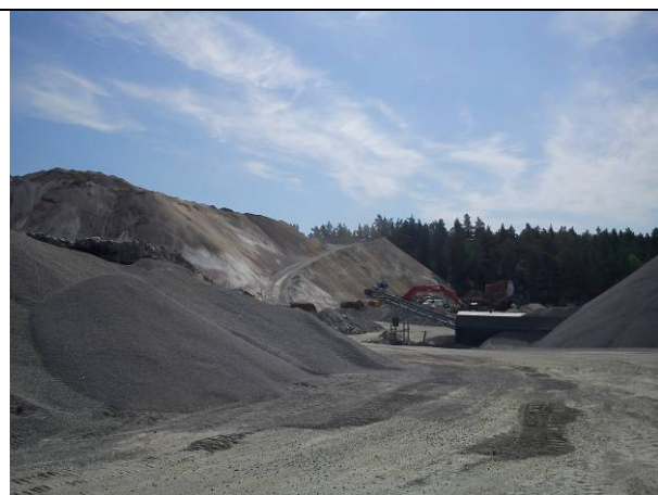
Oversiktsbilde – 0-stofflageret brun overflate viser at lageret er lutet
