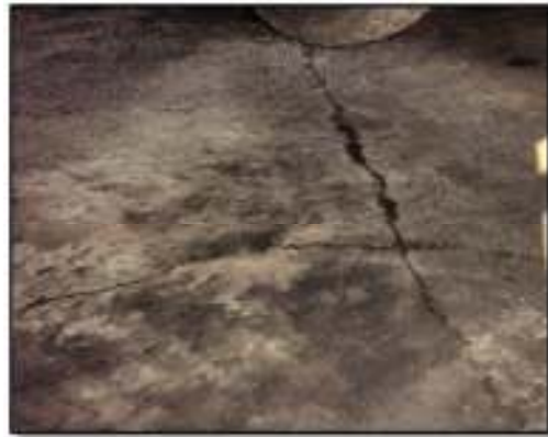
Tydelige sprekker i fast dekke. Foto: Fylkesmannen i Aust-Agder
