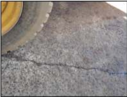
Tydelige sprekker i fast dekke. Foto: Fylkesmannen i Aust-Agder
