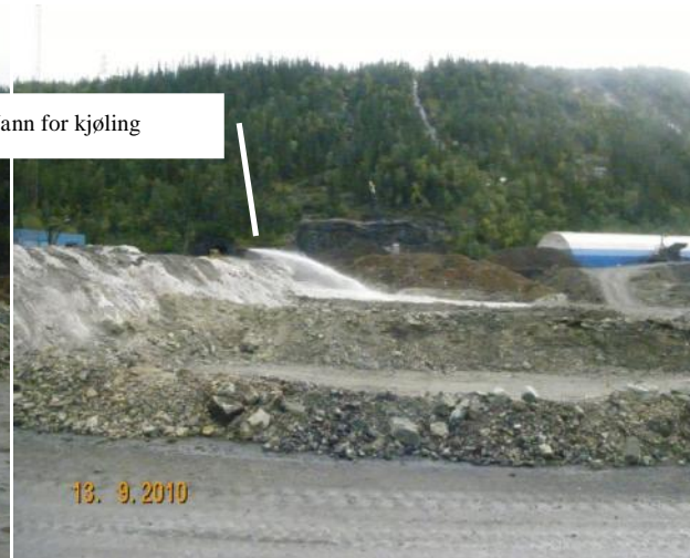
Bilde 2 Kjølebassenger og vannkjøling i bakgrunn
