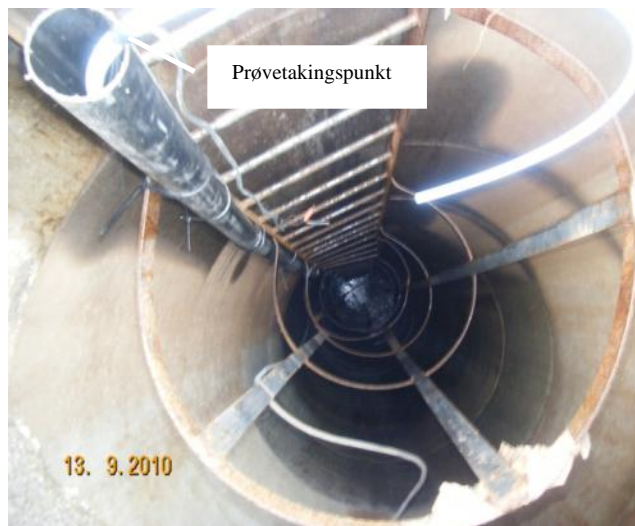
Bilde 8 Kontrollkum 2 med prøvetakingspunkt
