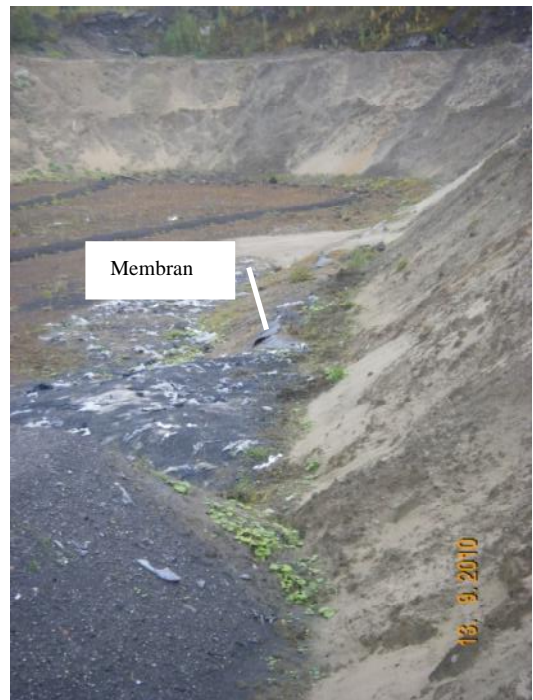
Bilde 2 Deponikant med membran delvis synlig
