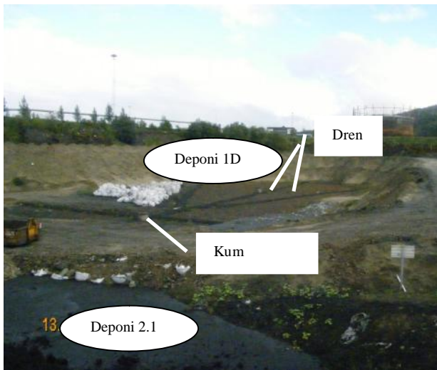
Bilde 1 Drensytstem synlig. Mellomlagring filterstøv i storekk
