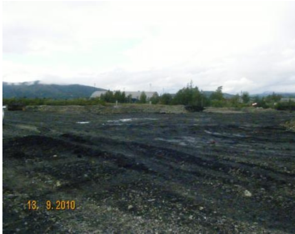
Bilde 3 Topp deponi med slagg dekke som bærelag
