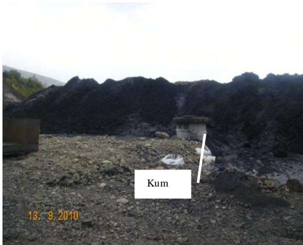
Bilde 5 Deponifront med kontrollkum sigevann fra deponi 1D i forkant
