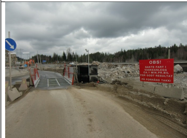
3 Vaskeplass for biler ved utkjøring
