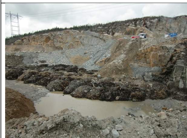
4 Vaskevann fra spyling av biler slippes ut i terrenget
