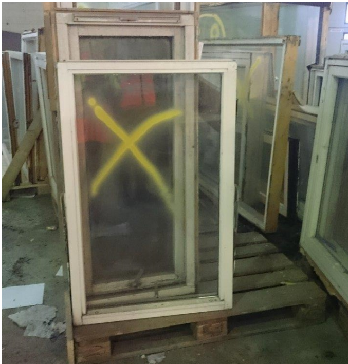
Bilde fra farlig avfallslager på Djupvik. PCB holdige vinduer ble kun spraylakkert med gult kryss.
