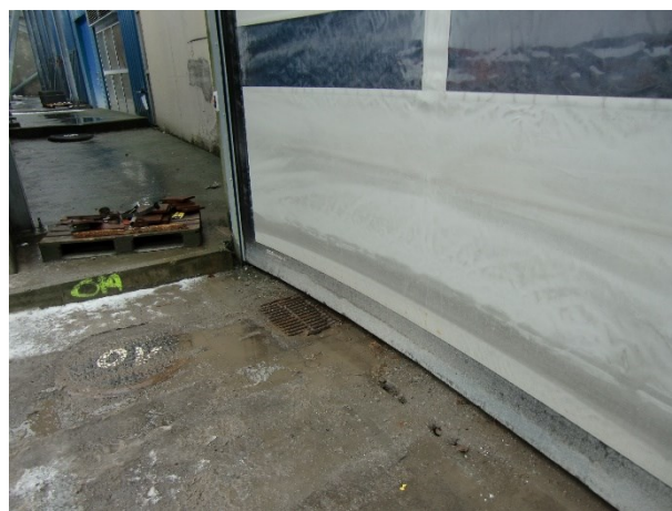
Figur 2 Sluk ved utkjøring av slagg
