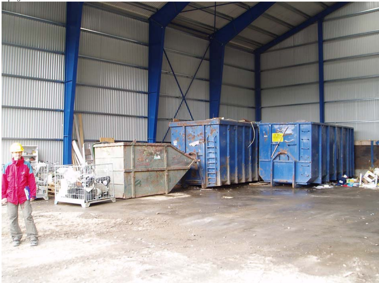
Sorteringshall. Fast dekke uten helning mot oppsamlingsrenne m.v.
