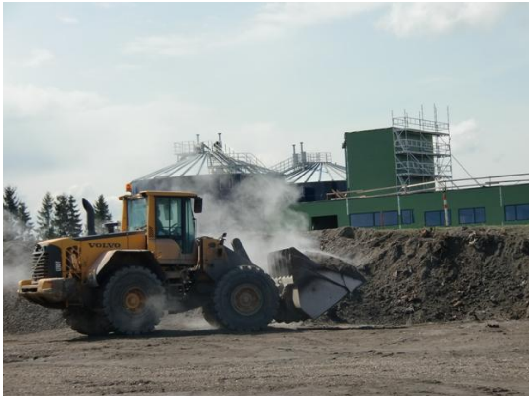
Askeanlegg – lasting av aske og slagg.
