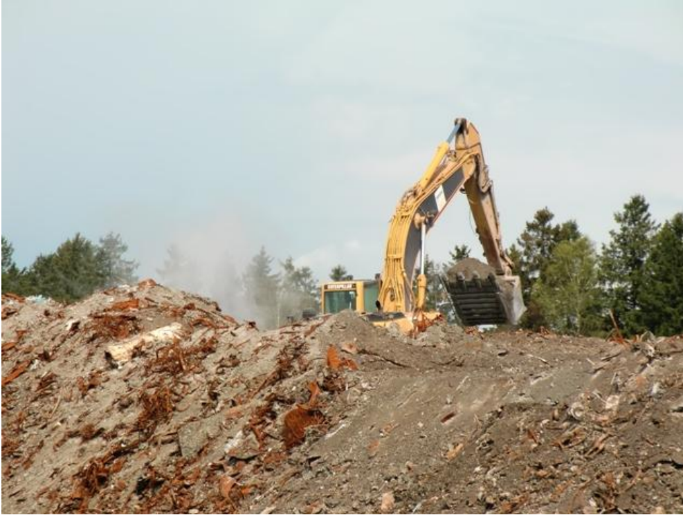
Fylling av aske og slagg på dumper for transport til sorteringsanlegg
