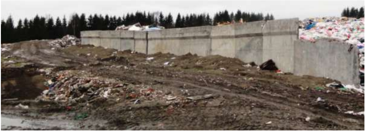
Betongavfall brukes som fyllmasse i veier på deponiet.
