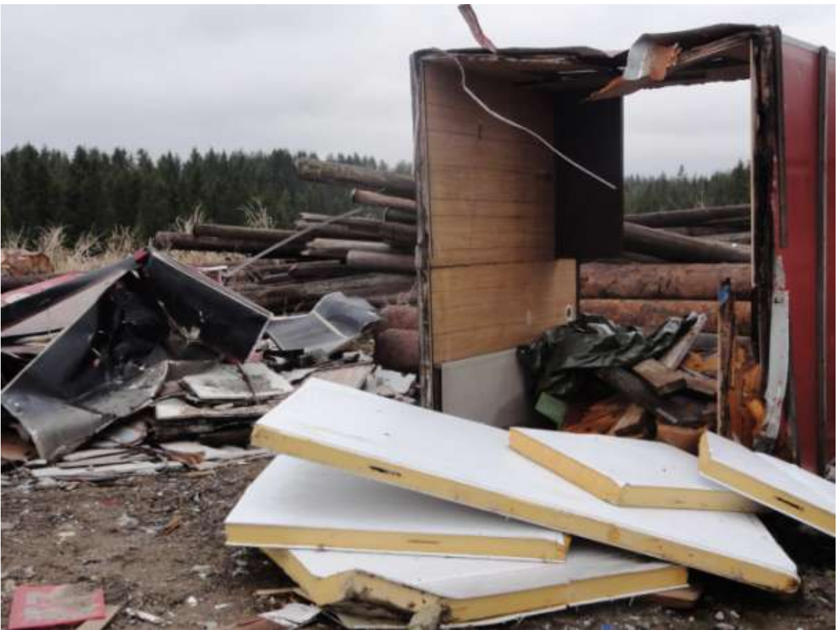
Ved sorteringsplaten: Sandwich-paneler med PUR (fra kjølerom?). Kreosot-stolper.
