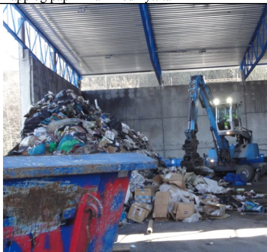
Restavfall i hall med nytt tak
