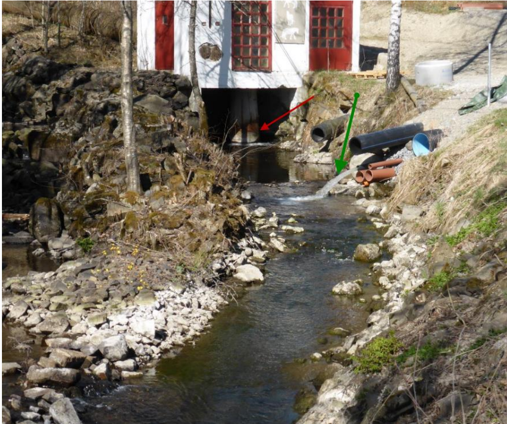
Bilde 2.2 - Vann fra kraftstasjon (rød pil) og skyllevann fra grovsil (grønn pil).
