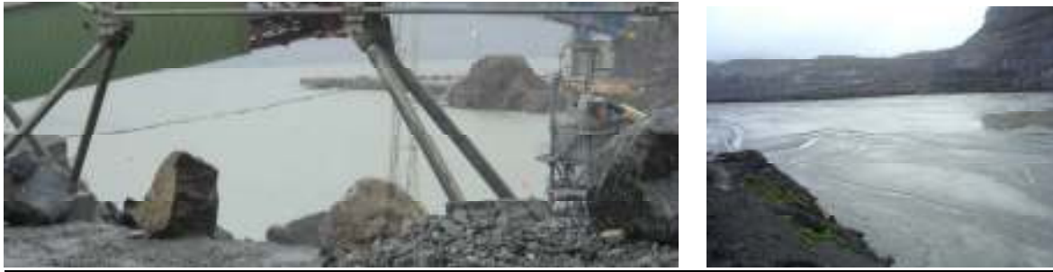
6: Utfyllingsområde m/silskjørt og påbegynt rampe for utfylling i sjø. 7: Sedimenteringsbasseng per 2012.
