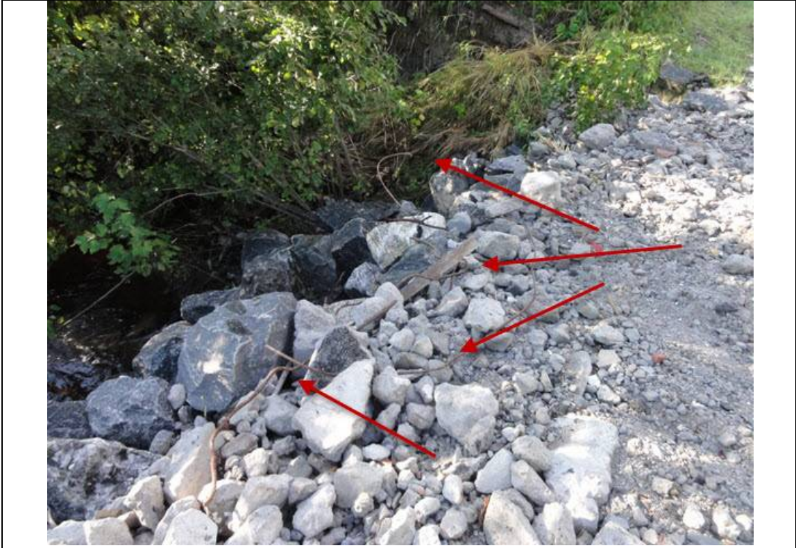
Bilde 1: Utfylling av betong med armeringsjern mot lokal bekk. Piler angir jernet. Foto ved Fylkesmannens miljøvernavdeling.
