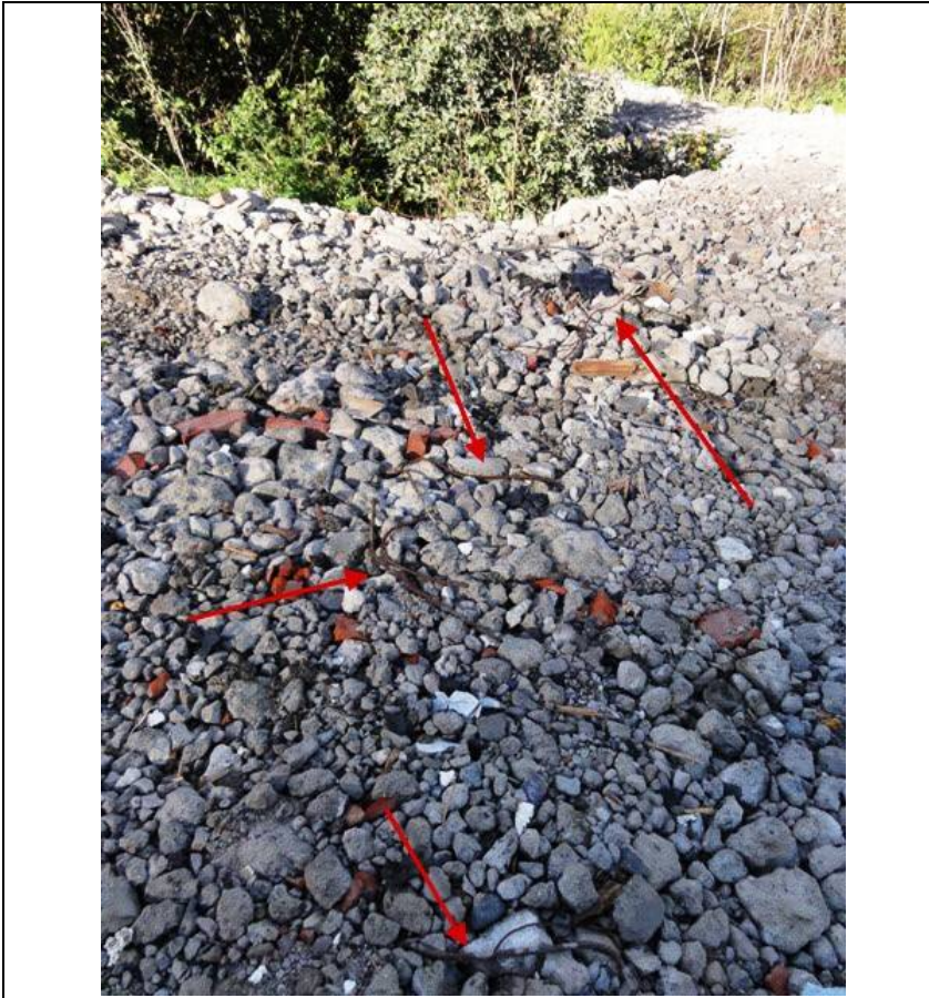
Bilde 2: Utfylling av betong med armeringsjern. Piler angir jernet. Foto ved Fylkesmannens miljøvernavdeling.
