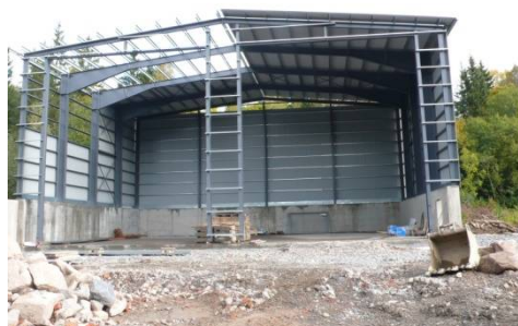
Nytt anlegg er under bygging
