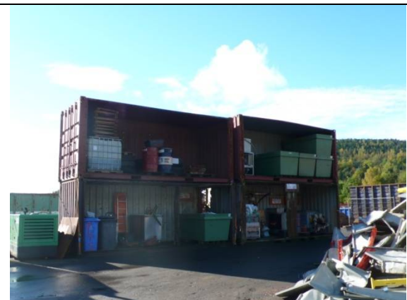
Containere for oppbevaring av farlig avfall (nederst)
