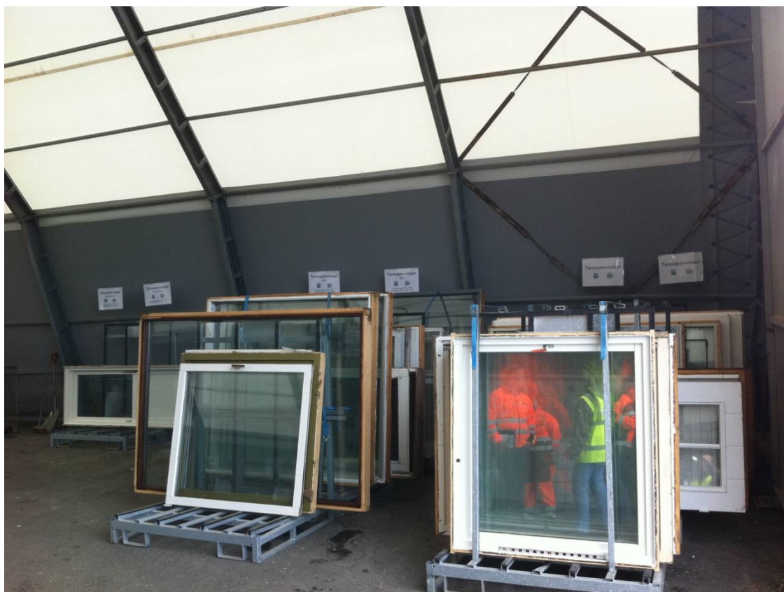
Bilde 2: Oppbevaring av isolerglassvinduer PCB/ klorparafiner
