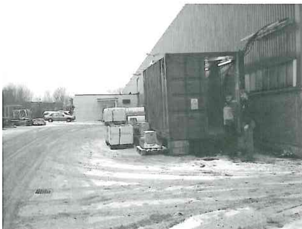
Overvannskum og container med renseanlegg (omvendt osmose + evaporator)
