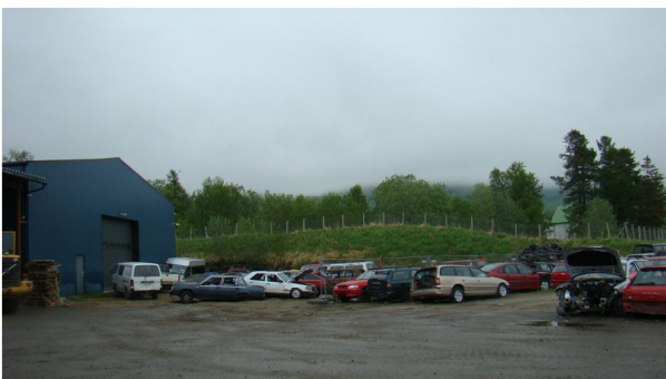
Bilde 8-9: manglende fast dekke.
