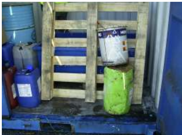
Bilde nr.1: Container for diverse farlig avfall mangler sikringskant. Bemerkt kjemikalierester på gulvet.
