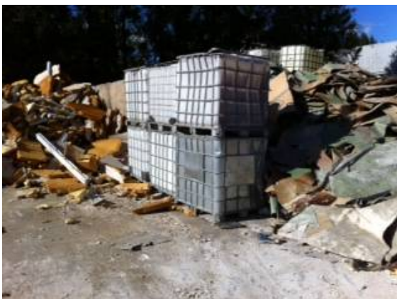
Figur 3 Lagring av farlig byggavfall, vinylbelegg og PUR-skum
