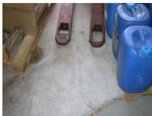
Bilde 4: Kjemikalier oppbevares ved sluk i gulv.
