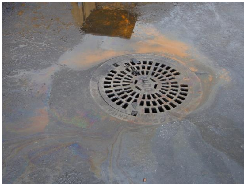
Oljeavrenning til sluk.
