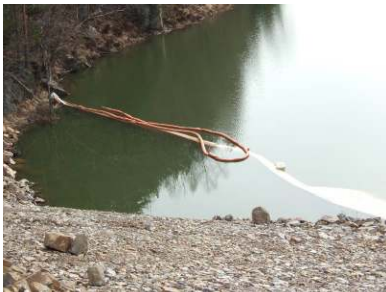
Utfylling ved Kvikksivann (siltskjørt lagt ut i etterkant)
