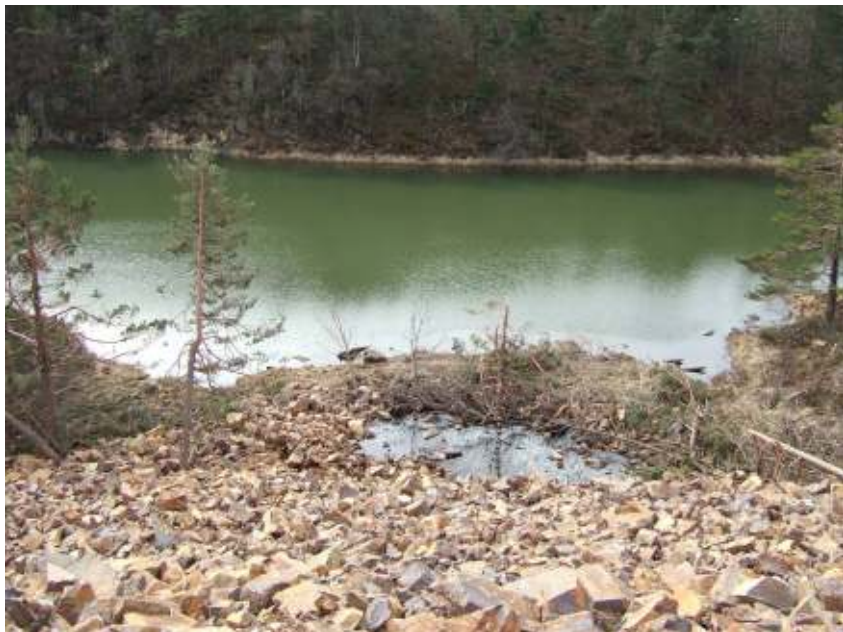
Utfylling ved Kvikksvann – ikke siltgardin
