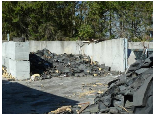
Lagring av takpapp/tjærepapp
