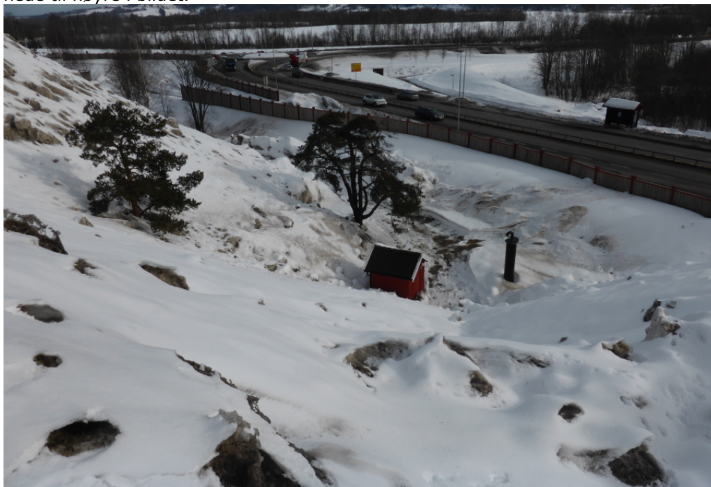
Bilde 2: Deponiet mot RV 159 og sandfangskummene.
