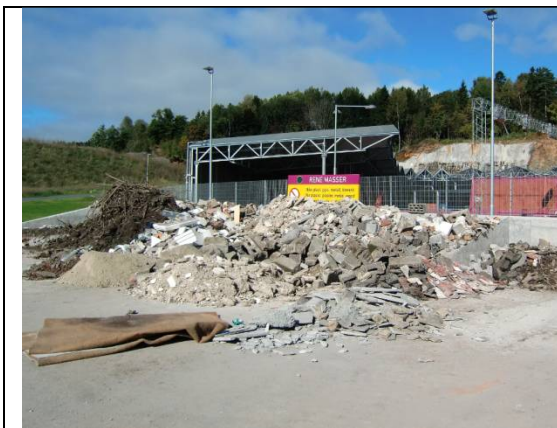
Lagringsplass for rene masser (Foto: Fylkesmannen i Oslo og Akershus)
