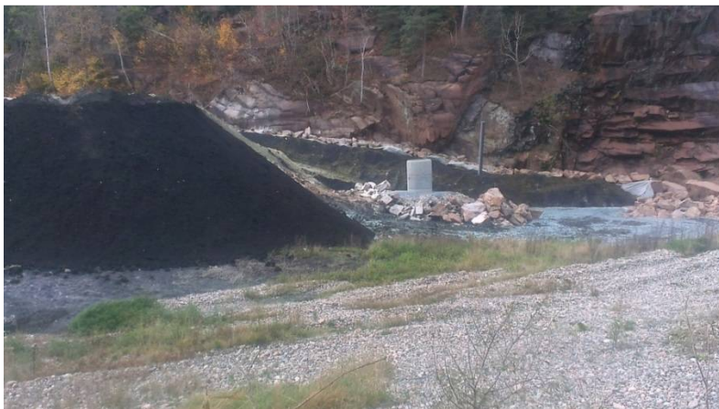
Enden av deponiet
