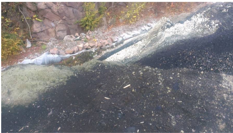
Kanten av deponi med dreneringsarrangement
