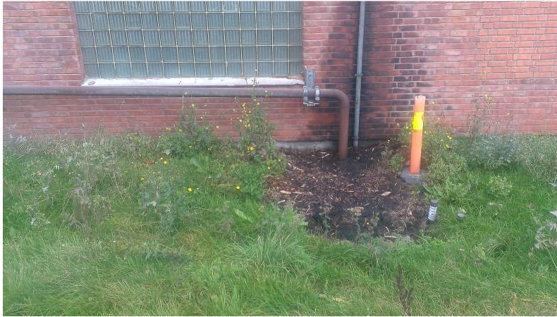
Område for nedgravd spilloljetank utenfor verksted
