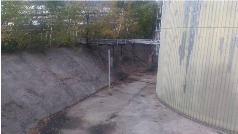
Lager tank for tungolje med oppsamlingsbasseng
