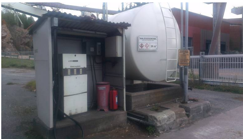
Dieseltank - påfyllingsstasjon for kjøretøyer
