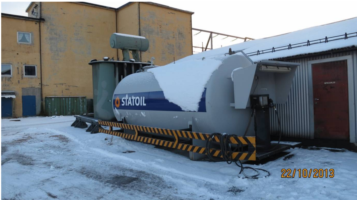
Lagertank for diesel.
