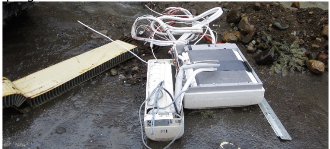
Bilde 13 og 14: Batteri og diesel lagra ute, batteriet på grusdekke
