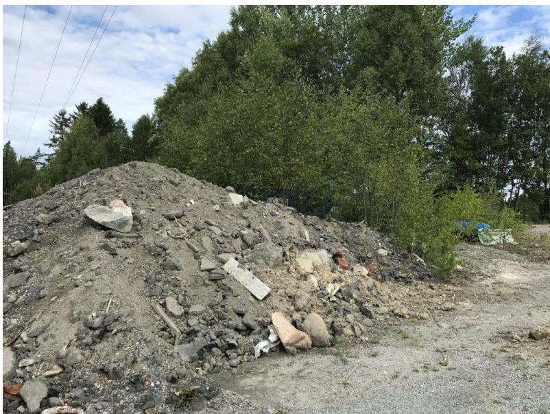
Knust betong lagret på grusdekke
