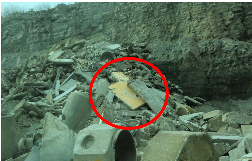
Bildet ble tatt på kontrolldagen og viser betongavfall med maling som er lagret på anlegget.
