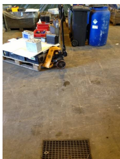
Rist i sorteringshallen som fører avløpet til oljeutskiljar Foto: Fylkesmannen I Hordaland 25.09.2013
