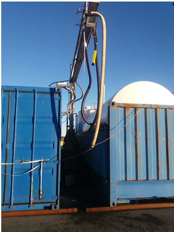
Slangebommen er sikret med wire
