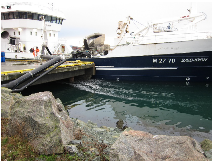
Bilde 2: Avrenning fra kaia ut i havna
