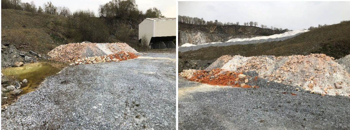
Bilder Midlertidig lagring av rivningsavfall
