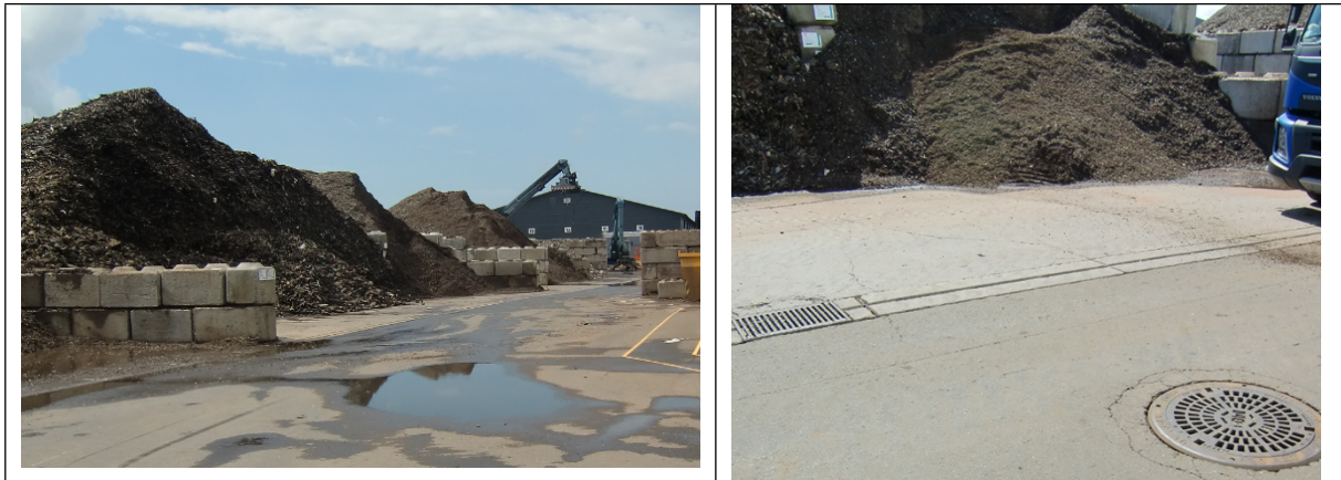
Lagring av restfraksjoner ved overvannskummer. Foto: Fylkesmannen i Oslo og Viken
