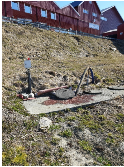
Bilde 1. Venstre: Fast materiale som går til sluk og avløp. Høyre: overløp ved kum
