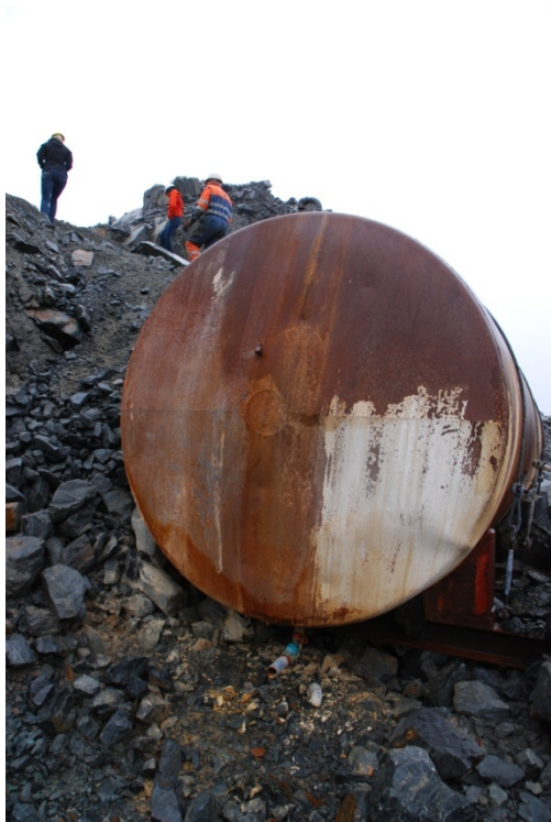
Bilde 1. Prøvetakingskran er ikke sikret mot uvedkommende.
