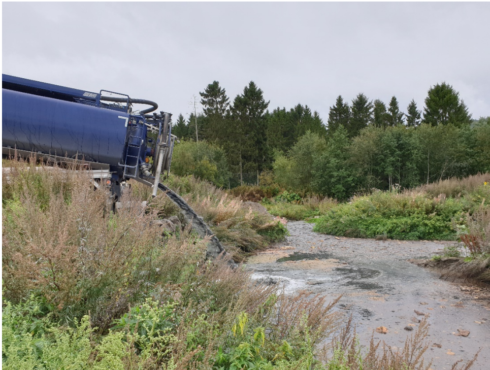
Bilde 3 Tømming av ristgods og sand fra sandfang i lagune på deponiet (Foto: Fylkesmannen i Trøndelag 12.09.2019)
