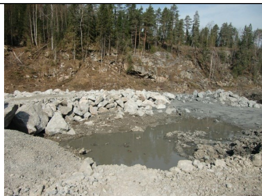
Figur 3 Steinfylling mot kvikkleire
