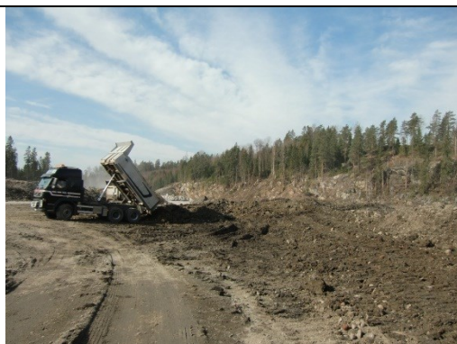
Figur 2 Tipping av masser på deponiet
