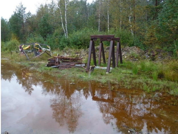
Bilde 1: Viser stor ansamling vann på baksiden av bygget. Oljefilm ses på overflaten.
