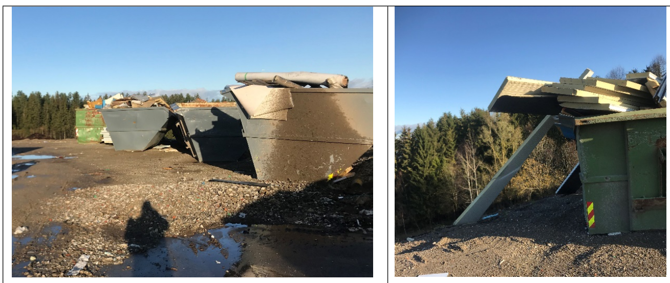
Figur 1 Konteinere med gulvbelegg og PUR skum
