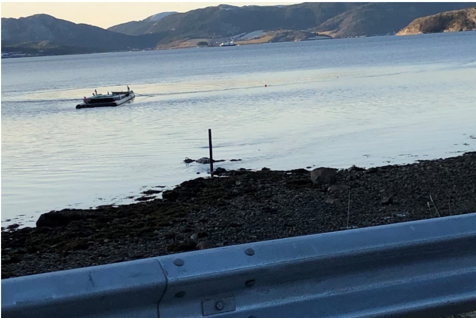
Lufterøret i strandsonen der avløpsvannet kom ut under høyvann
