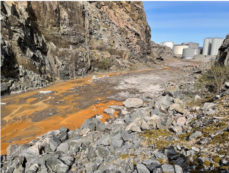
Figur 3: Sigevann har rent utover flaten i områder som ikke har dobbelbunntetting.
