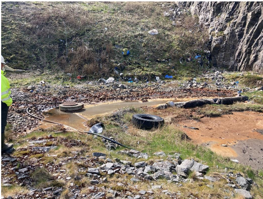
Figur 4: Tilstopping skjedde ved kummen på bildet.
