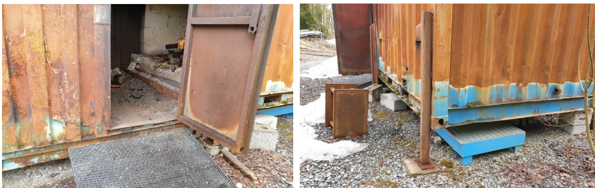
Bilder av brannkontaineren med oppsamlingskar under i blått. (Foto: Line Andersen, Statsforvalteren i Innlandet.)
