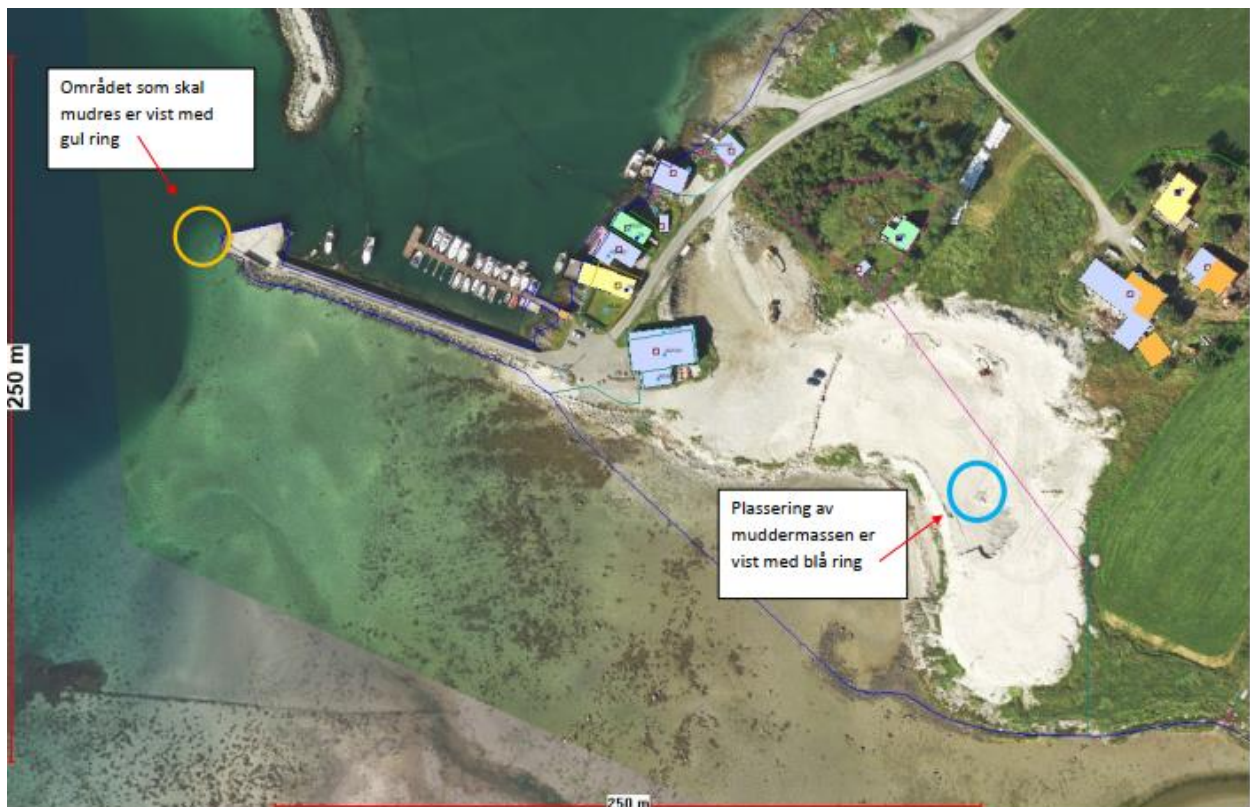
Figur 1 Oversiktsbilde Viksjøen havn. Området som skal mudres er markert med gul ring. Området der massene skal mellomlagres er markert med blå ring. Bildet er hentet fra søknaden..
