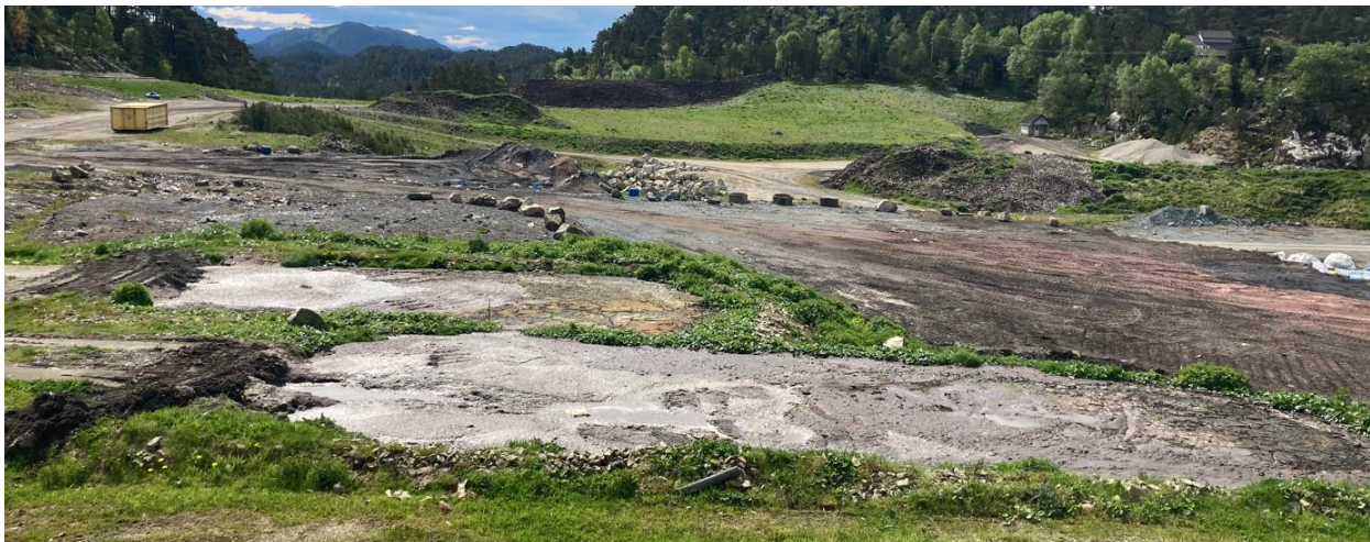
Bilde: avvatning av avløpsslam og sandfangs-massar oppå deponiet
