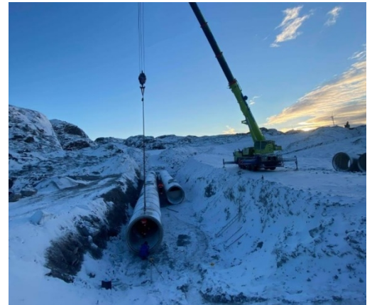
Figur 3. Plassering av sedimentasjonsrør ved KNA
