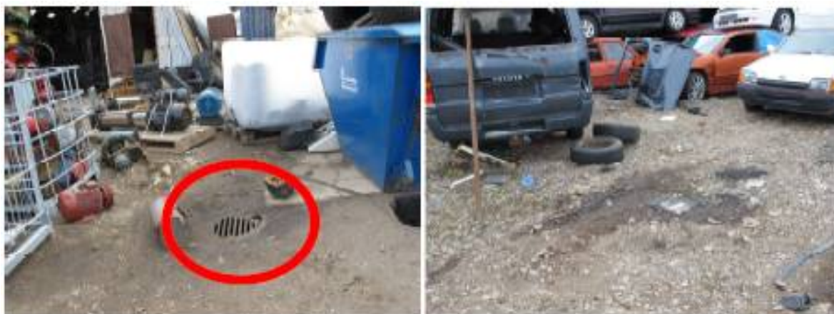
Bilde 2. Sluk til oljeutskiller utenfor området med fast, ugjennomtrengelig dekke og tydelig oljesøl i område hvor usanerte/sanerte biler har blitt lagret i påvente av videre behandling.
